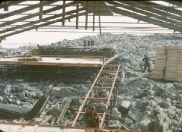
La base Dumont d'Urville en cours de construction.
